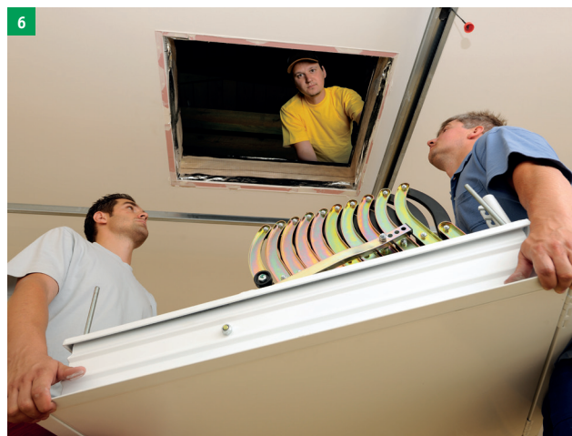
6 dvě osoby vyzvednou schody do stavebního otvoru
