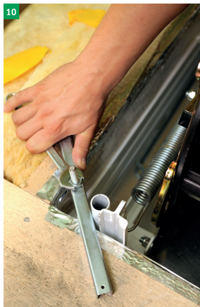
10 řádné utažení 4 ks kotevních šroubů
