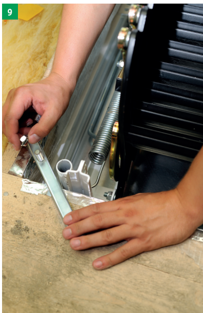
9 třetí osoba, která je již v půdním prostoru pomocí 4 ks nosníků upevní rám
