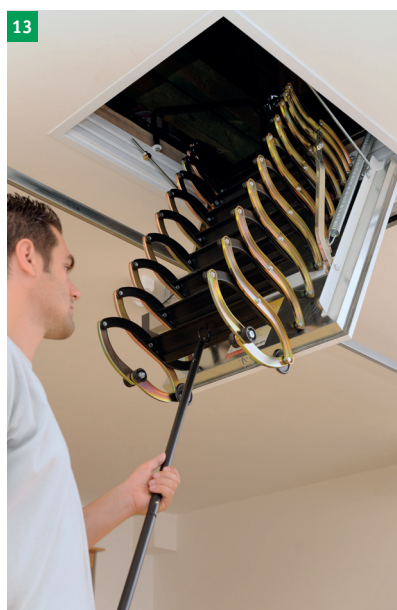
13 stažení schodů pomocí stahovací tyče
