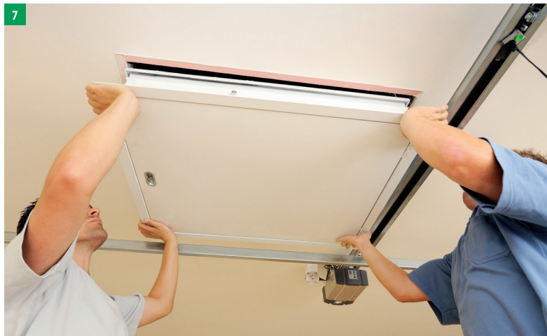
7 vsazení schodů do stavebního otvoru
