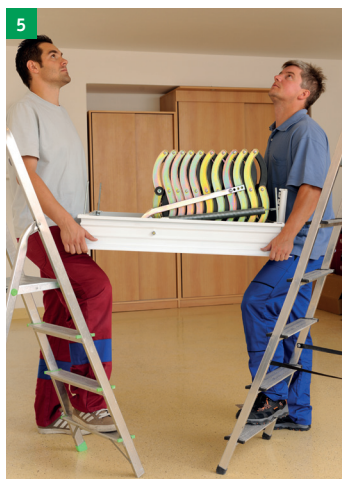
2 kontrola dodaného typu a rozměru stahovacích schodů
