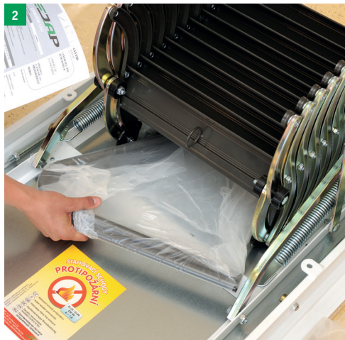
2 kontrola dodaného typu a rozměru stahovacích schodů
